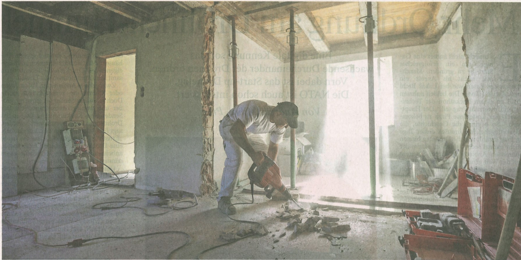
An die Arbeit: Vor der Sanierung sollte der Architekt die Altbausubstanz bewerten – dafür ist allerdings eine freie Honorarvereinbarung möglich.
